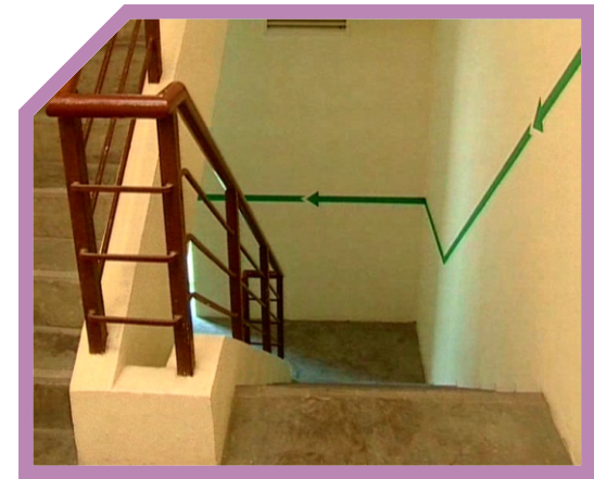
LÀM VỆ SINH CẦU THANG BỘ THOÁT HIỂM
