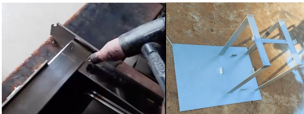
Hình 2-19 Gia công kết cấu khung cơ khí
