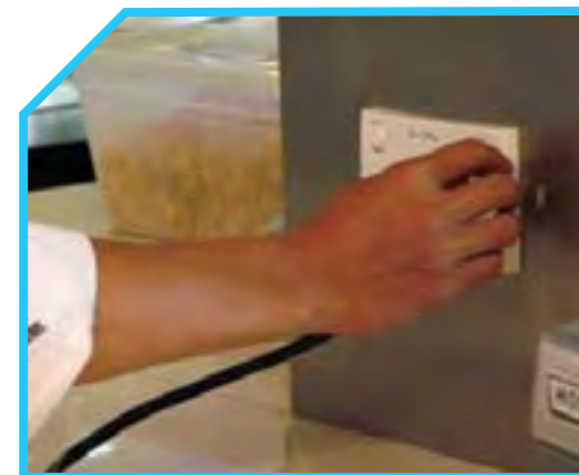
TẮT NGUỒN ĐIỆN TRƯỚC KHI KIỂM TRA
