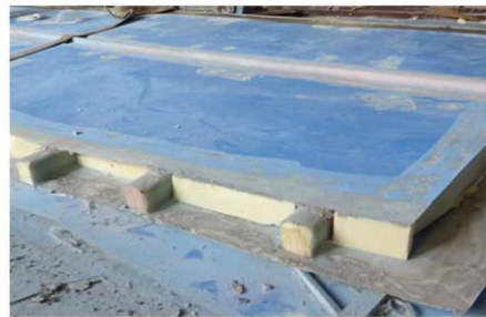
Hình 2: Kết cấu 3 lớp (sandwich)
